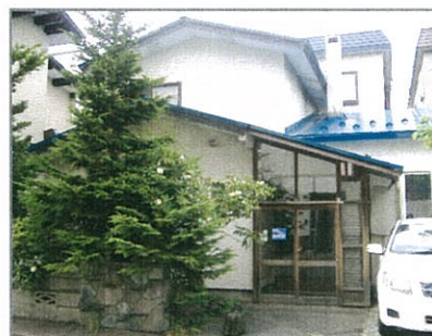
↑ 事業所の外観 青い屋根の2階建てです。
